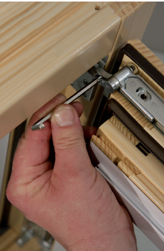
3. Am Sicherheits-Tresorband oben den Verriegelungshebel öffnen (per Hand oder mit Inbusschlüssel 4 mm)
