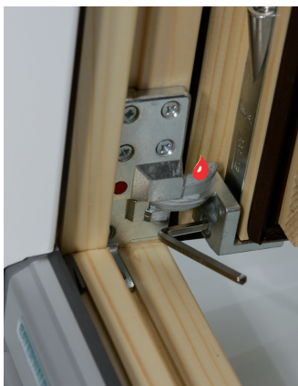
Seitenverstellung unten +/- 2 mm
