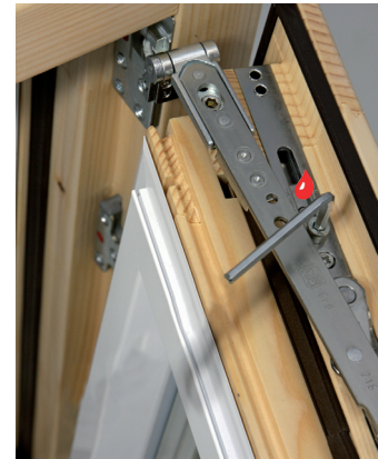
Flügelandruckeinstellung an der Schere oben +/- 1 mm
