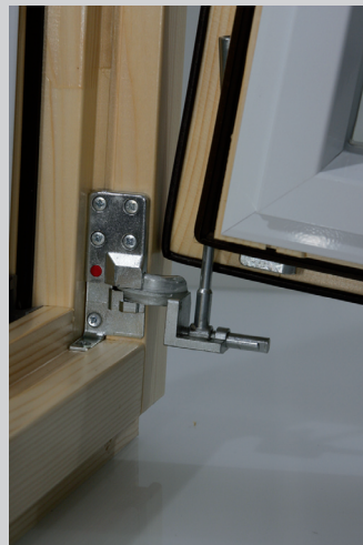
2. Flügel einhängen, Flügel in den Achsstift einführen
