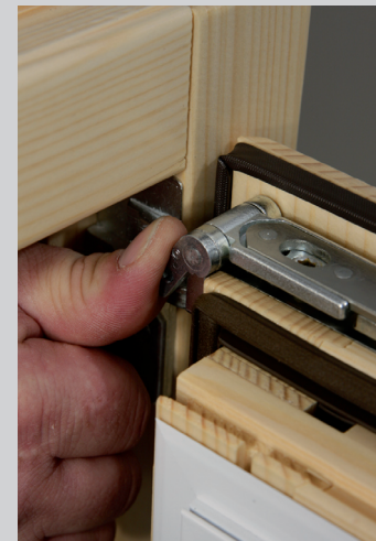
3. Scherenarm einhängen und Arretierhebel schließen (per Hand oder mit Inbusschlüssel 4 mm)
