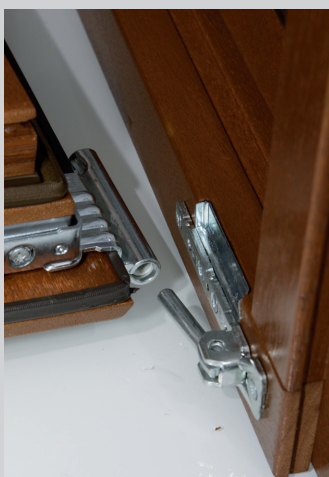
1. Flügel im unteren Ecklager einführen
