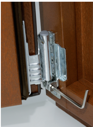
Seitenverstellung unten +/- 2 mm
