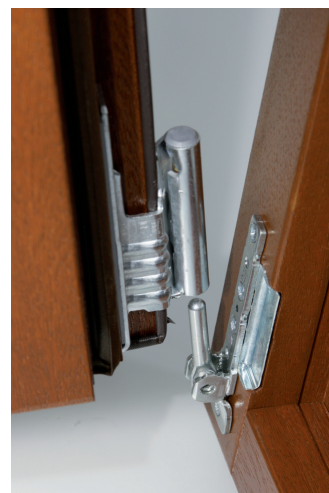
5. Flügel aus Ecklager unten heraus ziehen
