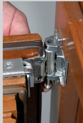
3. Sicherungsbolzen eindrücken
