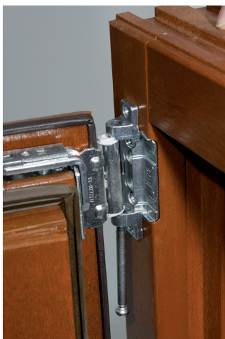
4. Fenster oben, bei Bandlenker herausziehen
