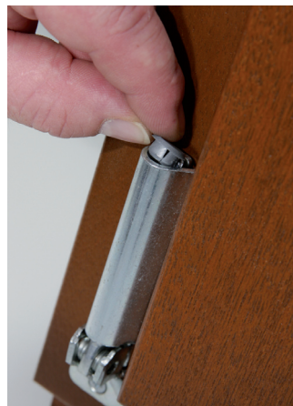
Höhenverstellung Verschlußkappe entfernen (Schutz vor Verschmutzung)
